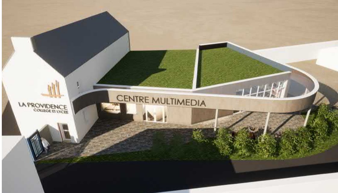
Vue extérieure du projet de pôle multimédia permettant de voir le bardage bois et le traitement paysagé.
